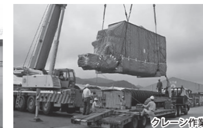
クレーン作業
