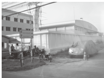
新たに整備された防水壁
